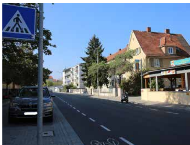
Abbildung 4: Bebelstraße nach dem Ausbau (W4)
