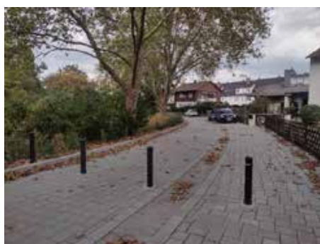
Die Pfrimmanlage nach dem Straßenausbau
