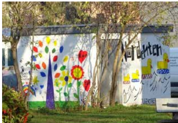
EWR-Trafo Station nach der Bemalung
