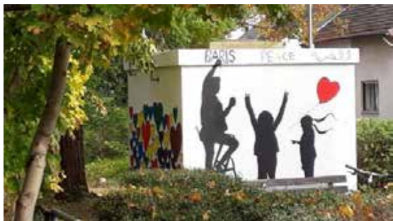
EWR-Gashäuschen in Neuhausen
