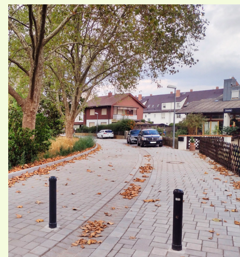
Straßenausbau an der Pfrimmanlage nun fertiggestellt
